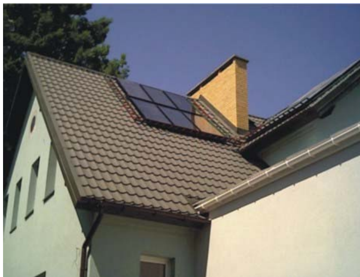
Widok dachu z baterią słoneczną, złożoną z 6 paneli po stronie południowo-wschodniej.
