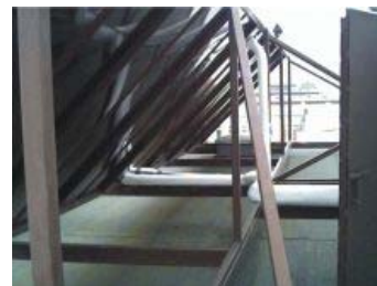
Konstrukcja stalowa po wzmocnieniu
